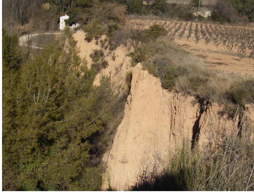
Marge excavat d'una unitat de llims i sòls quaternaris que presenten un gran espessor
