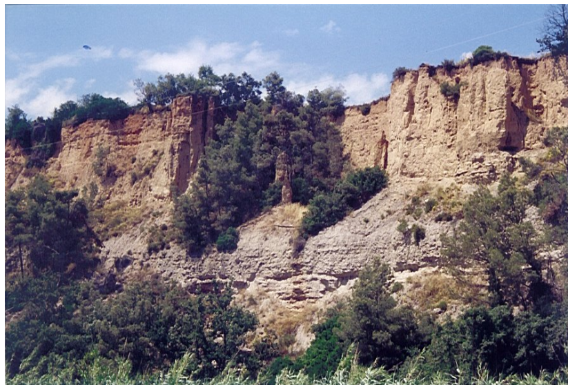
Marges excavats pel riu Anoia amb diferents processos d'erosió i estabilitat del talussos
